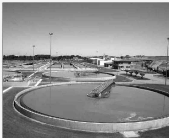
Panorámica de las instalaciones de la Edar de la capital / LADOIRE
