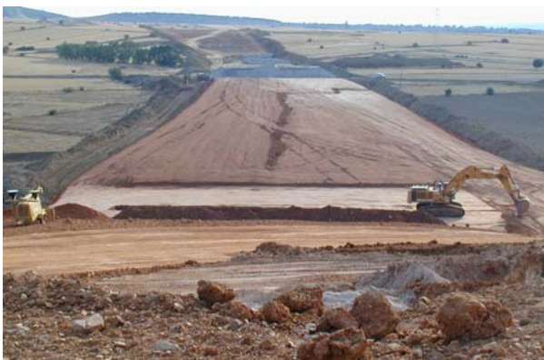
Zanja sobre la clave del tubo de drenaje
