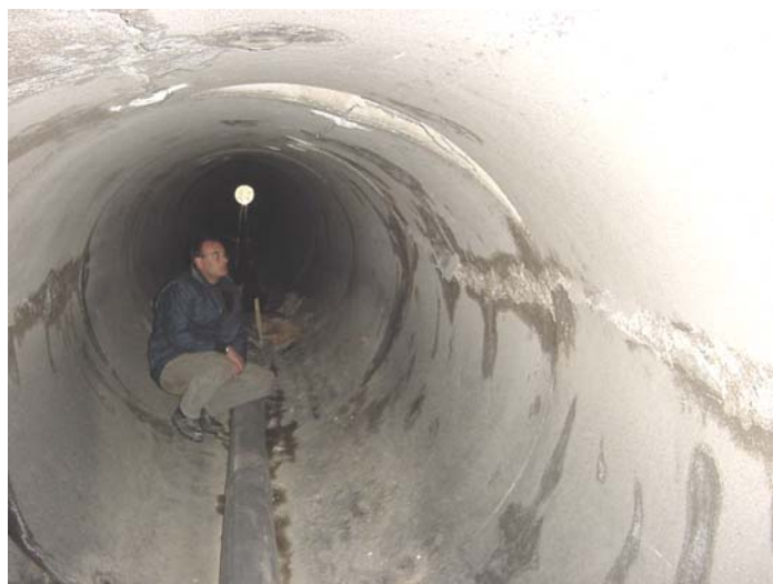
Fotografía de rotura de tubería que se proyectó con zanja inducida y no se ejecutó
