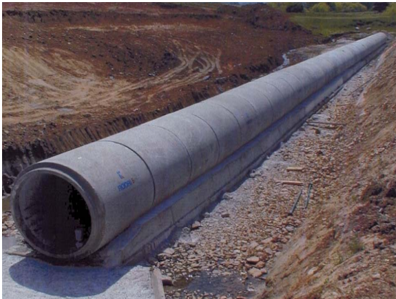
Tubería colocada en cama de hormigón a 120° y clase UNE 135, en toda la longitud
