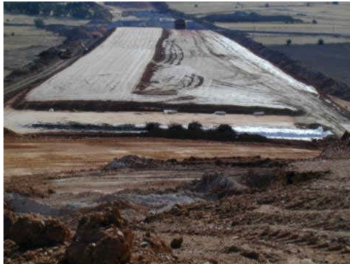
Zanja inducida en autopista Ávila
